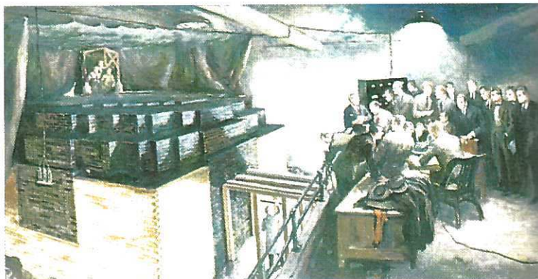
Figura 43-8 Desenho do primeiro reator nuclear, construído durante a Segunda Guerra Mundial, por um grupo de cientistas comandado por Enrico Fermi, sob a arquibancada do estádio da Universidade de Chicago. O reator, que se tornou crítico no dia 2 de dezembro de 1942, era feito de camadas alternadas de tijolos de grafita pura e tijolos de grafita contendo cilindros e esferas de urânio e óxido de urânio. Reatores semelhantes foram usados mais tarde para produzir plutônio para a fabricação de armas nucleares. (Gary Sheenan, Birth of the Atomic Age , 1957. Reproduzido por cortesia da Chicago Historical Society)
